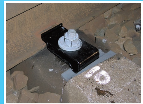
ネジ山再生工法
