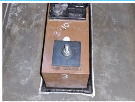
まくらぎ止め工法
